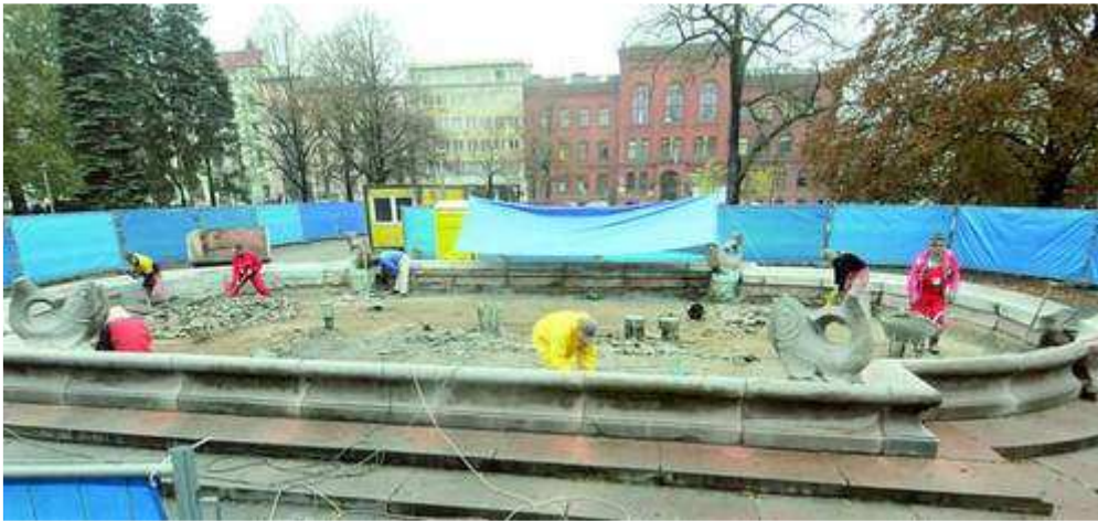
W parku Kazimierza Wielkiego już trwają prace w miejscu, gdzie stanie fontanna Potop (Fot. Tytus Żmijewski)
